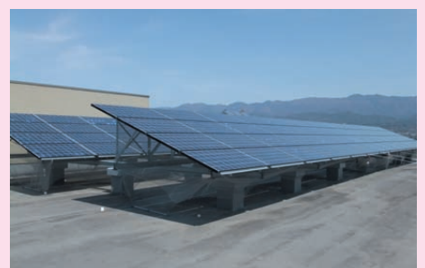
屋根に設置している太陽光発電
